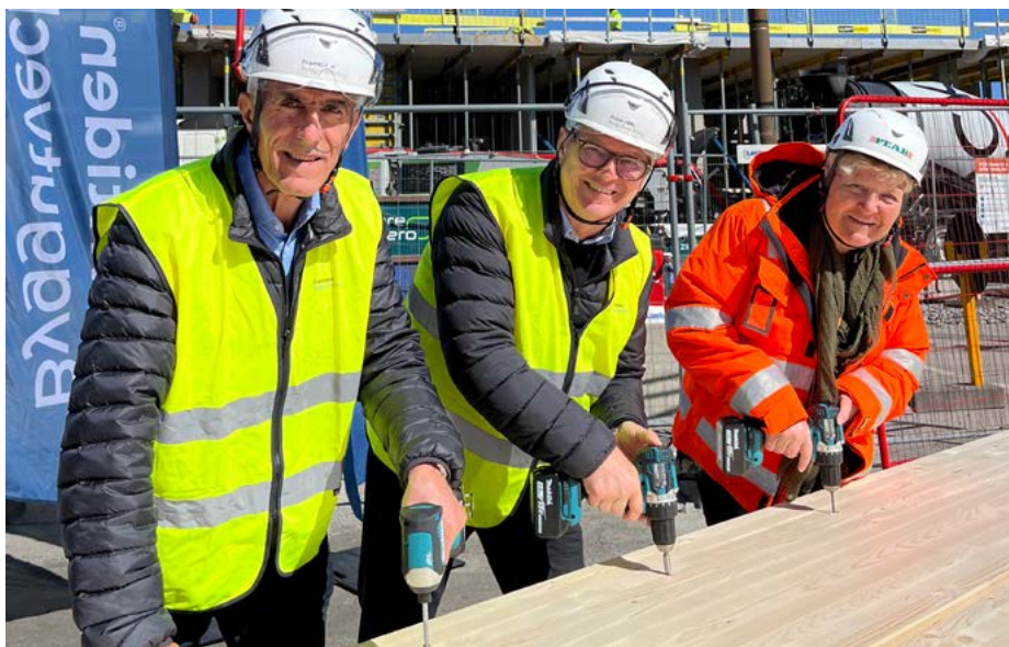
Skruvtag för kvarter G1b vid Masthuggskajen.
